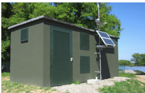
Photo 5 : Exemple de poste de livraison (Total Quadran)
